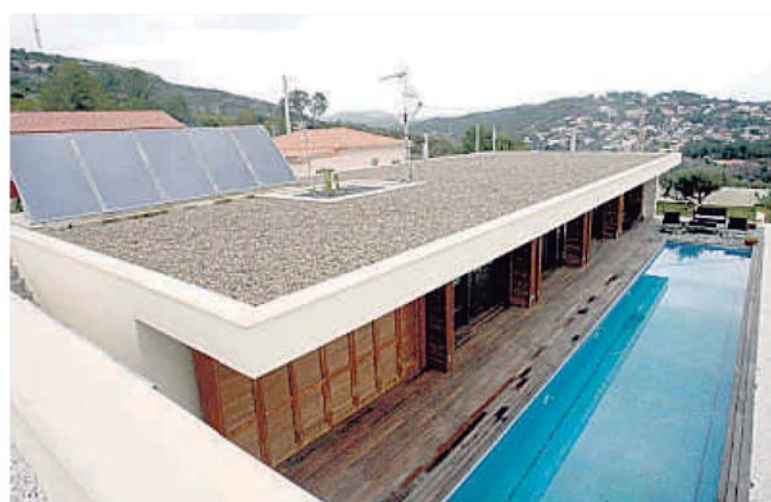
Les plaques solars serveixen per escalfar l'aigua i per la calefacció
